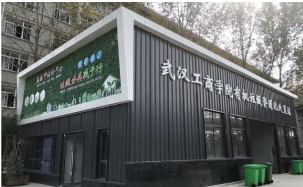
图 33 武汉工商学院有机垃圾资源化处置站
